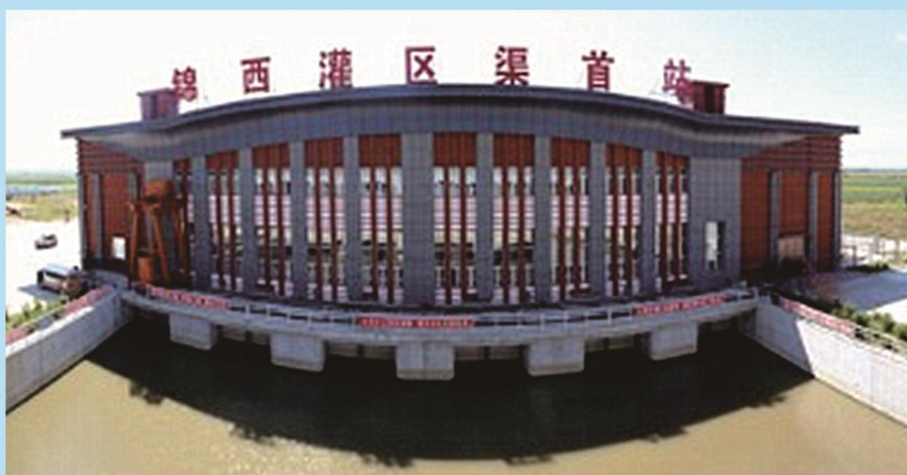
多速减速器应用于富锦市锦区灌区 2 \times 16\text{T} 多速卷扬启闭机上
